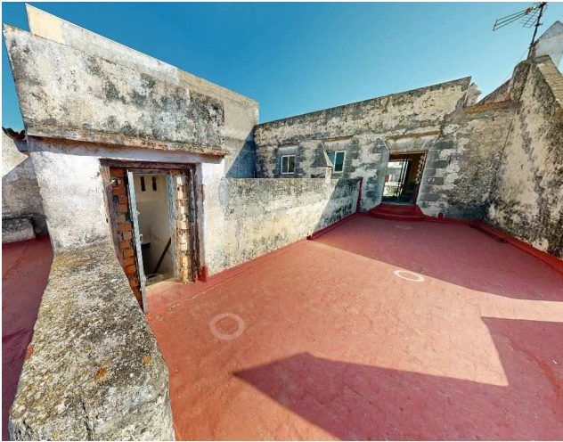
Terraza central de planta segunda y fachada del módulo edificado en planta segunda. En medianera derecha de acceso al módulo se observan los vestigios de la escalera preexistente de acceso a planta cubierta.
