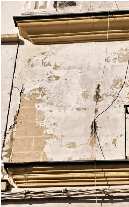
Detalle de fachada donde se observa el esgrafiado de la misma imitando la piedra, a nivel de planta segunda
