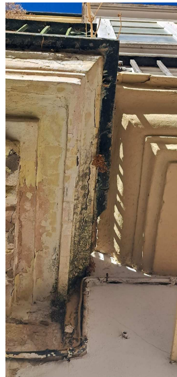
Detalle de fachada
