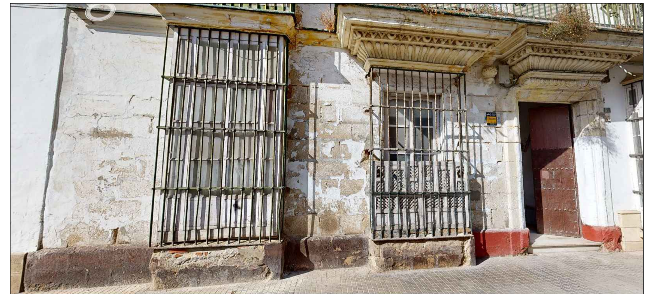
RECUPERACIÓN DE FACHADA PRINCIPAL
