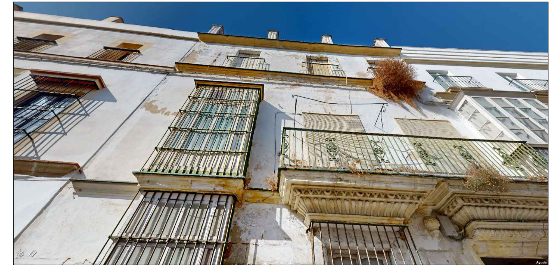
RECUPERACIÓN DE FACHADA PRINCIPAL
