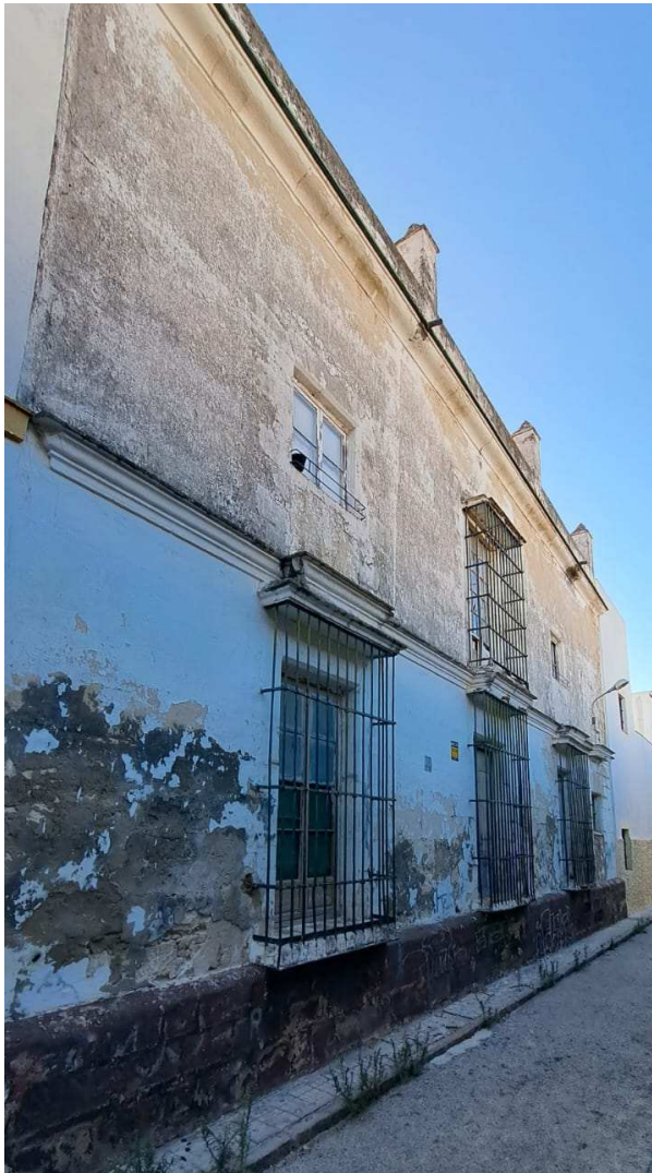
Fachada posterior de edificio a calle de la Palma
