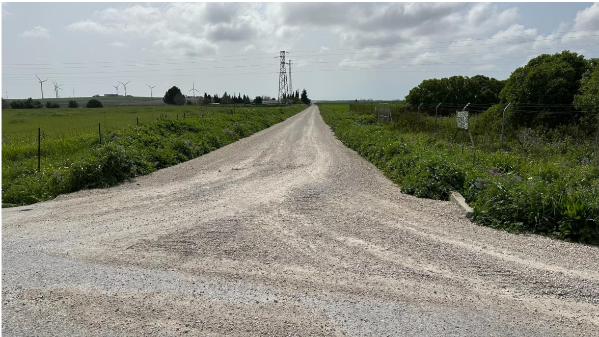
Ilustración 4-Acceso por cañada de las Huertas (acondicionada para el tráfico rodado)
