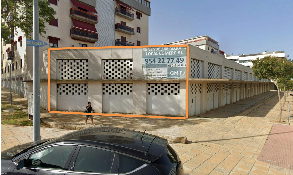
Fachada de Carretera de Sanlúcar
