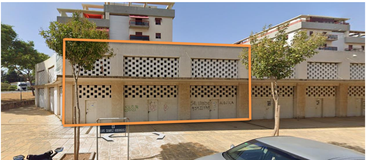
Fachada de calle Luis Suárez Rodríguez (Foto 1)
