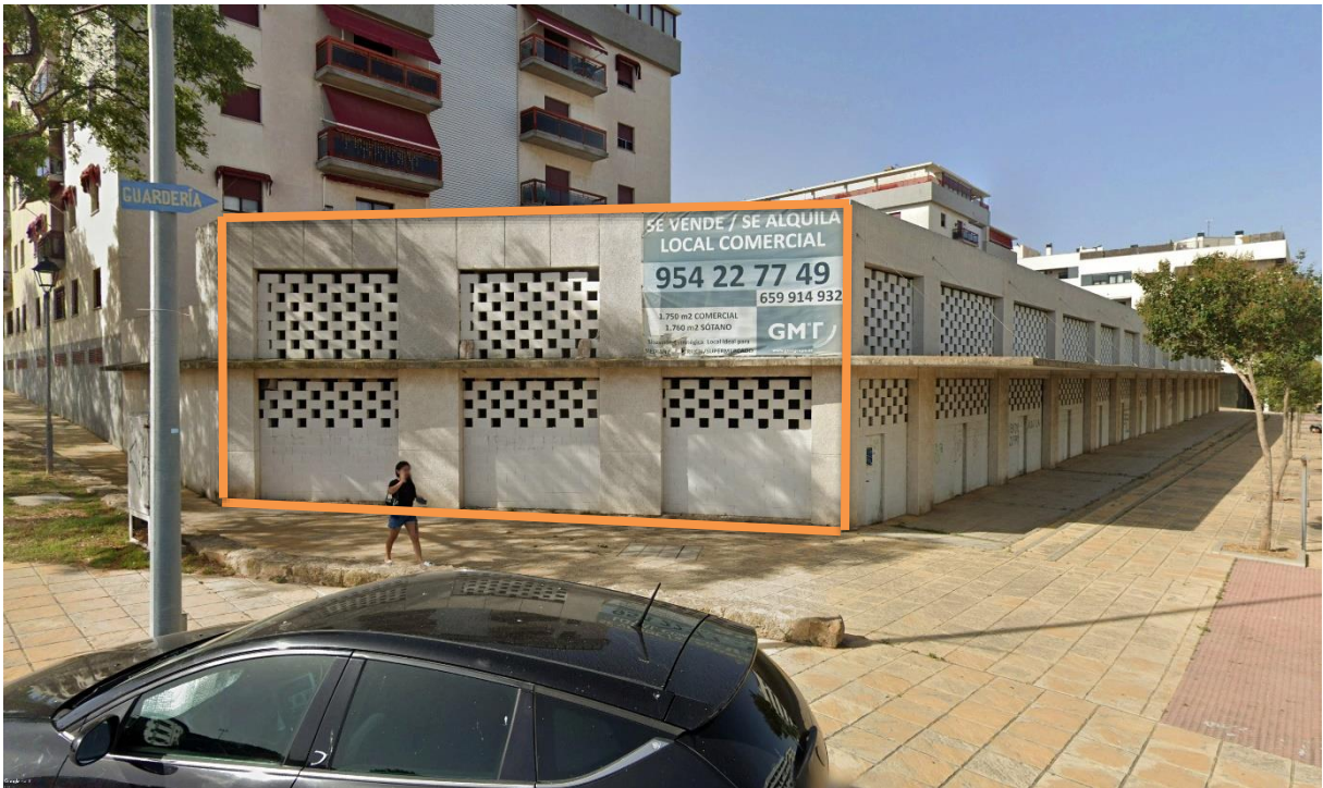
Fachada de Carretera de Sanlúcar (Foto 2)
