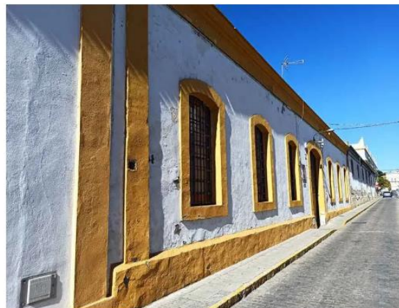
3. Bodega Cuvillo San Carlos
