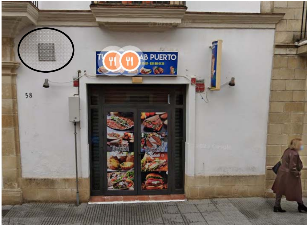
Salida de humos existente en la fachada del establecimiento
