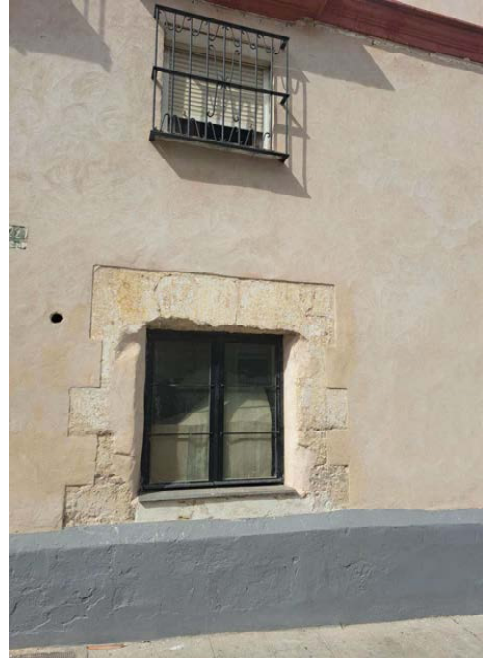
Fotografía N9. Ventana de local a calle San Sebastián
