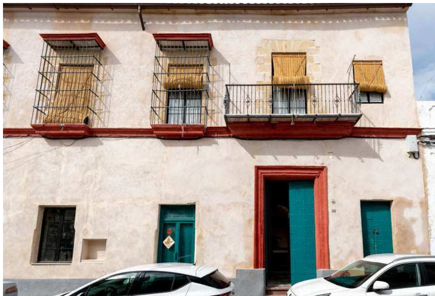
Fotografía N6. Fachada a calle Cruces
