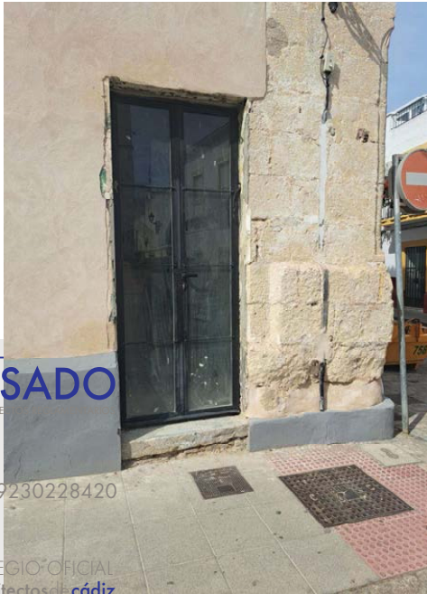
Fotografía N10. Puerta de local y esquina de calle San Sebastián con calle Cruces
