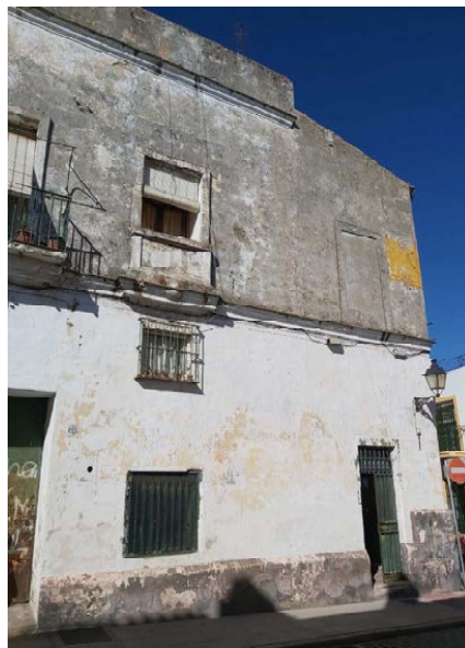
Fotografía N4. Fachada a calle San Sebastián.
