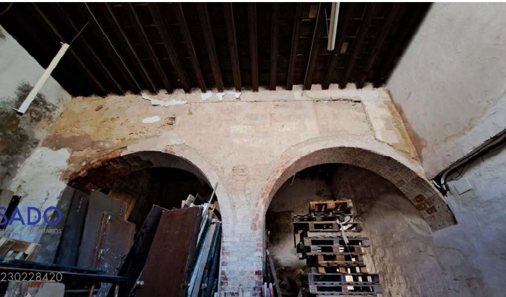
Fotografía N27. Zona de usuarios.
