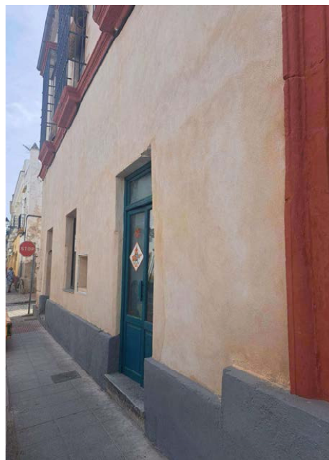
Fotografía N13. Fachada de local a calle Cruces, vista 2
