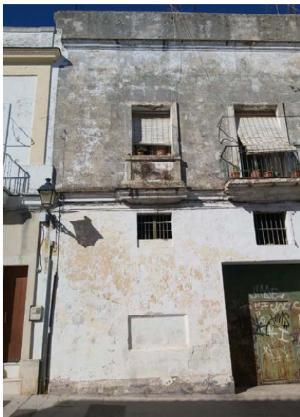
Fotografía N3. Fachada a calle San Sebastián.
