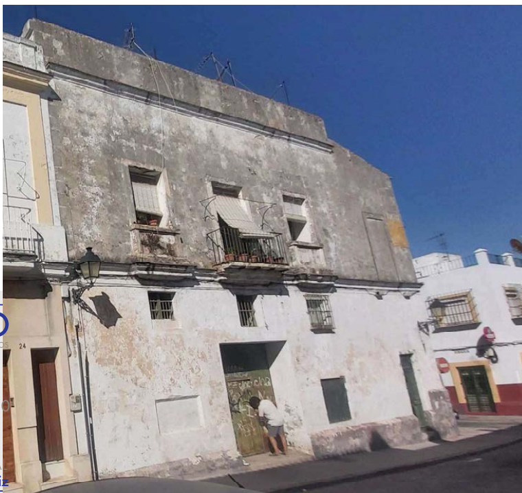
Fotografía N5. Fachada a calle San Sebastián.
