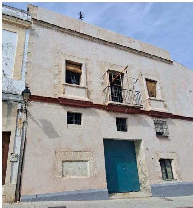
Fotografía N7. Fachada a calle San Sebastián
