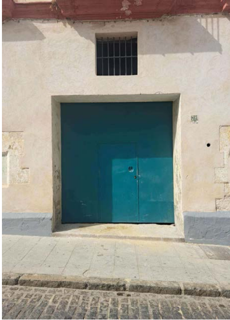
Fotografía N8. Puerta de local a calle San Sebastián
