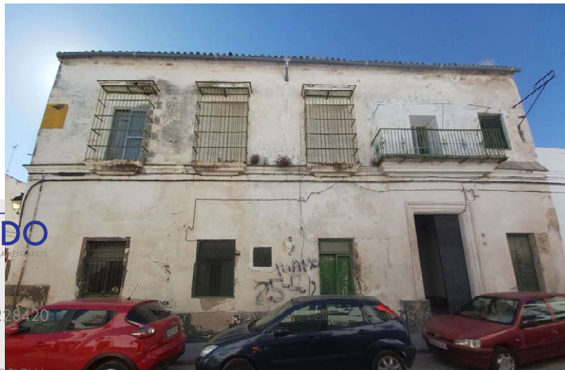
Fotografía N2. Fachada a calle Cruzes
