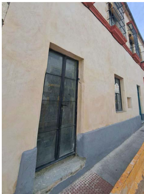
Fotografía N12. Fachada de local a calle Cruces, vista 1
